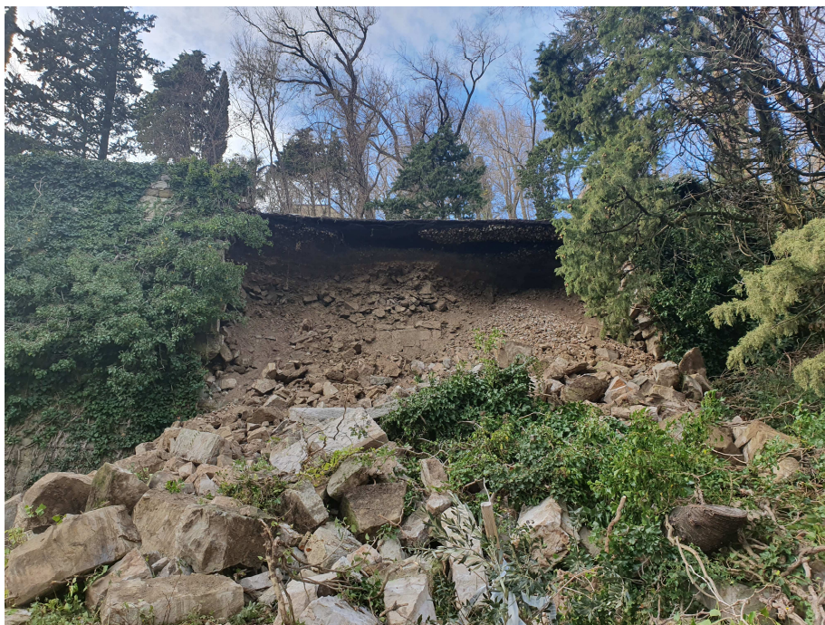
Foto n.1 vista muro collassato da pastino inferiore
