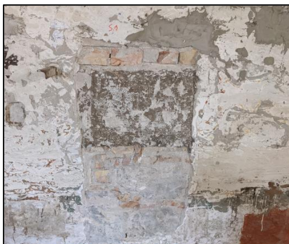
Figura 8 - Muratura mista in pietra e ricorsi di mattoni pieni
