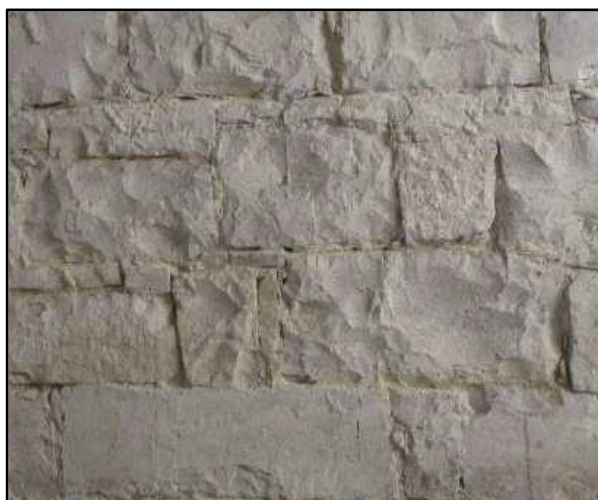
Figura 7 - Muratura in pietra a spacco con buona tessitura
