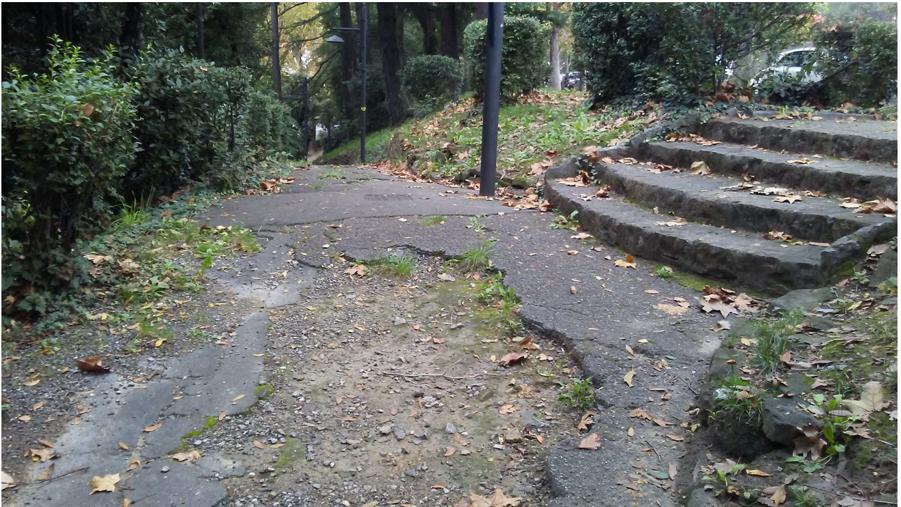
FOTO 5 - DEGRADO PAVIMENTO IN ASFALTO
