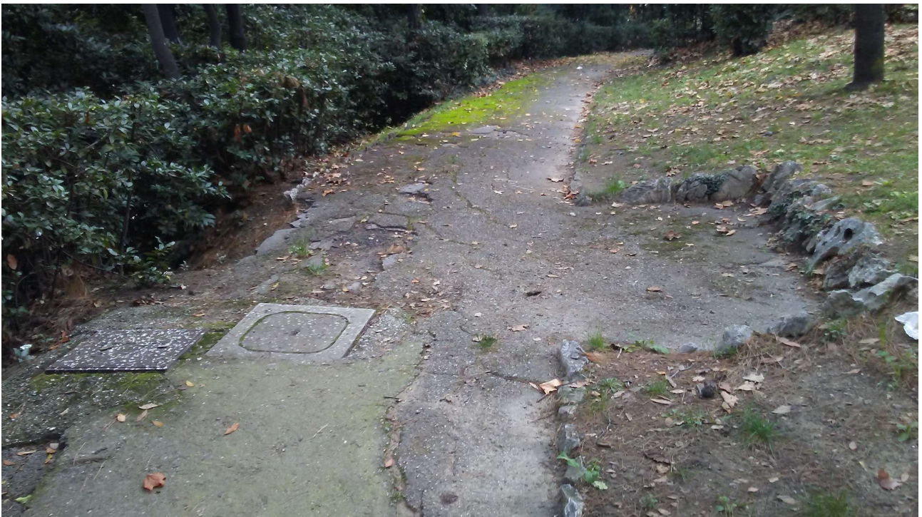
FOTO 4 – CEDIMENTI LATO SCARPATA A VALLE PER SCORRIMENTO ACQUE PIOVANE
