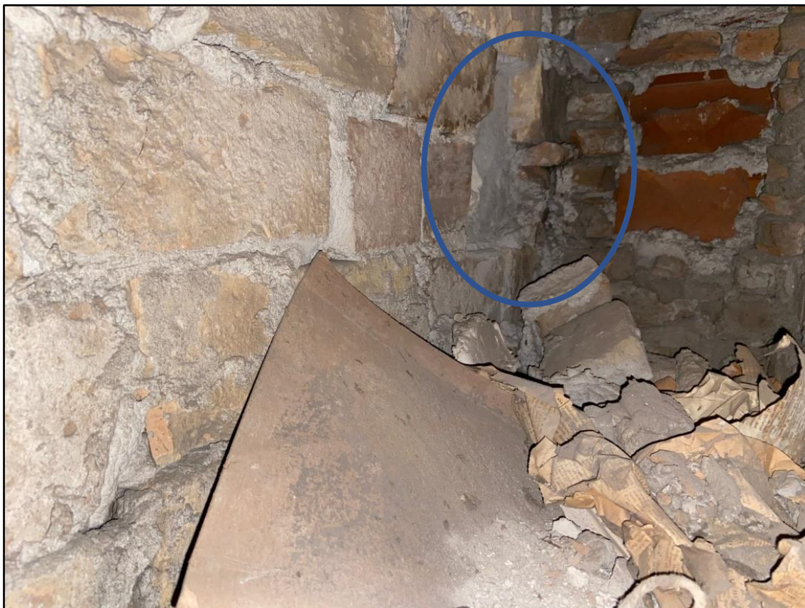
Figura 28 - Intercapedine tra le pareti in mattoni di taglio con parziali crolli all'interno della stessa
