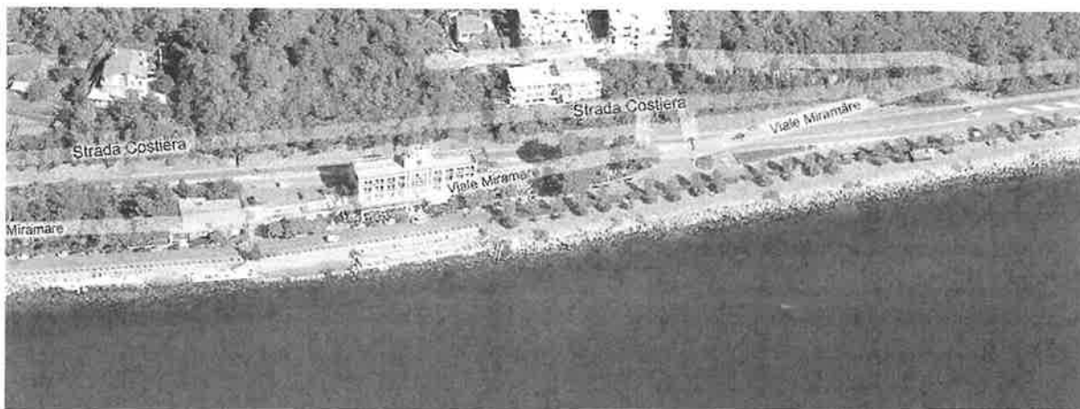
piattaforma in località “Bivio”
