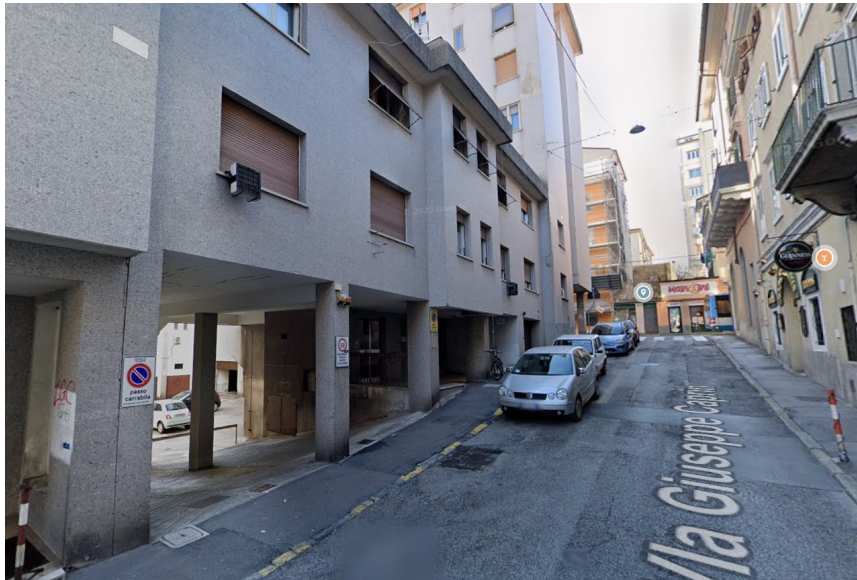
Ex Centro Civico di Via Caprin (Immagine Google Street View)
