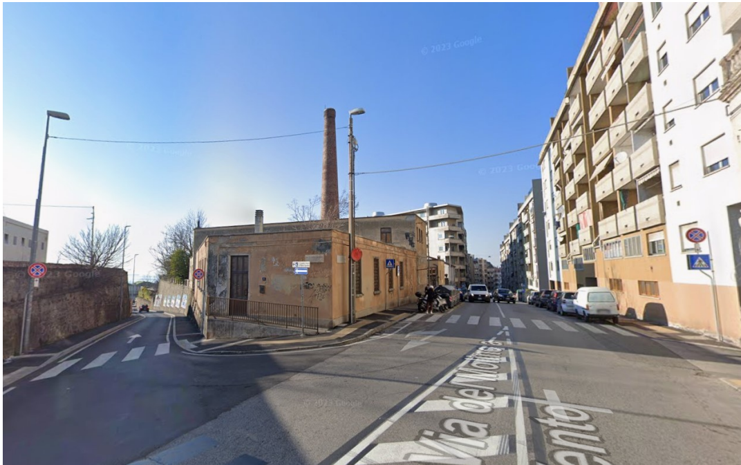
Ex Stabilimento Disinfezione. L'edificio in primo piano sono gli ex uffici del Medico Condotta. A sinistra Via Marenzi (Immagine Google Street View)
