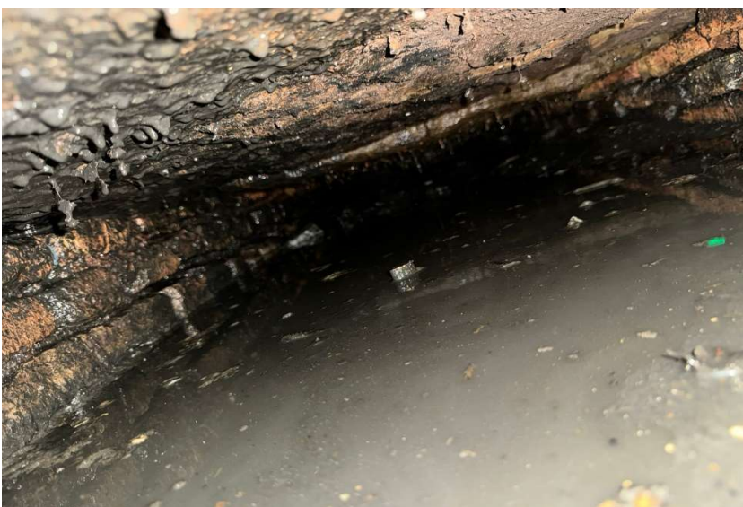
Fig.3-4) Canale in muratura sotterraneo e relative immissioni
