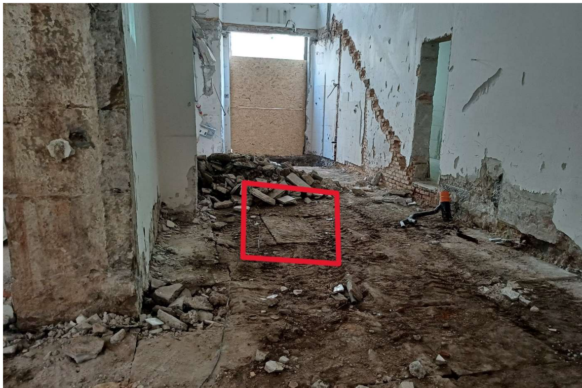
Fig. 6) Individuazione chiusino del pozzo sotto la pavimentazione esistente
