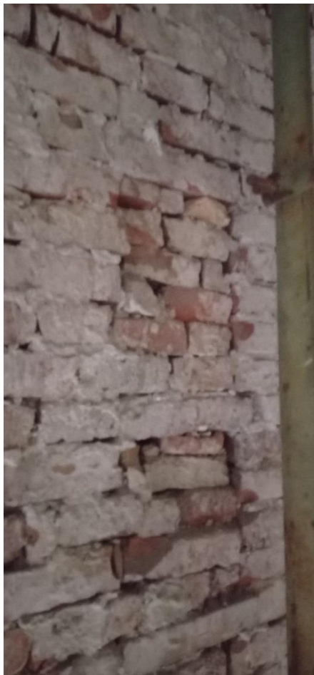
Lesioni localizzate nel paramento murario
