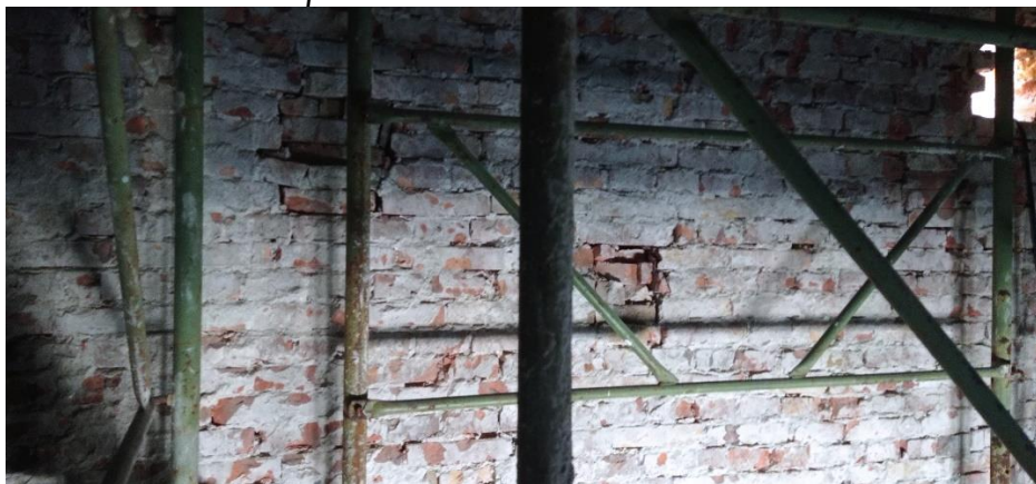
Lesioni localizzate nel paramento murario
