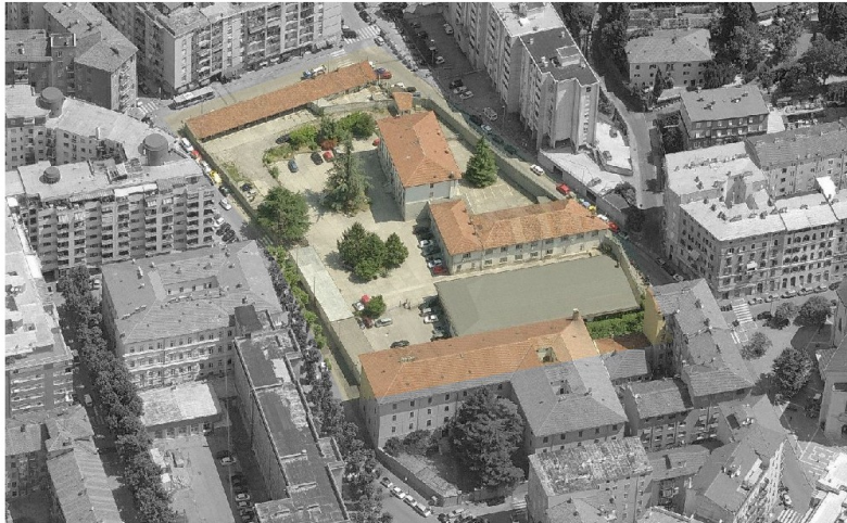
vista aerea da sud
