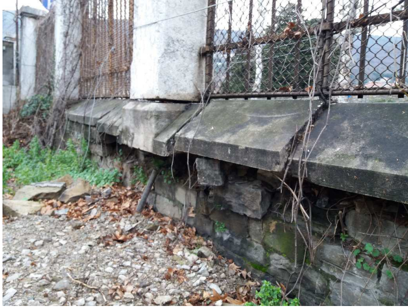
FOTO N.2 PARTICOLARE INTERVENTO BASAMENTO
