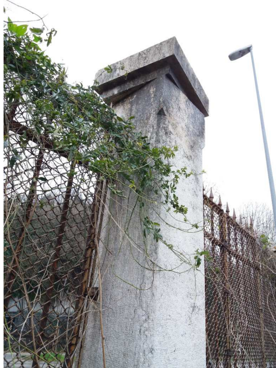
FOTO N.3 PARTICOLARE INTERVENTO PARTE ALTA
