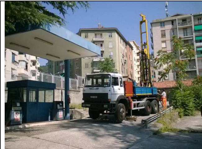
Foto 19: esecuzione sondaggio S9
