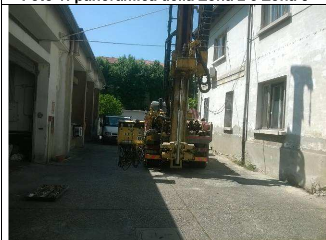
Foto 3: esecuzione sondaggio S1
