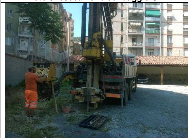
Foto 11: esecuzione sondaggio S5
