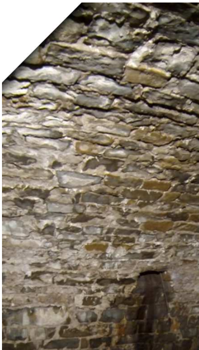
Vista verso Est
