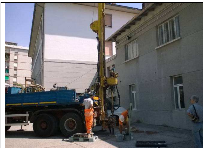
Foto 13: esecuzione sondaggio S6
