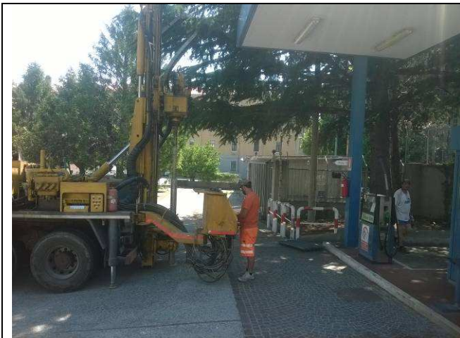
Foto 7: esecuzione sondaggio S3
