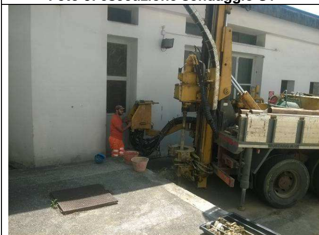
Foto 5: esecuzione sondaggio S2
