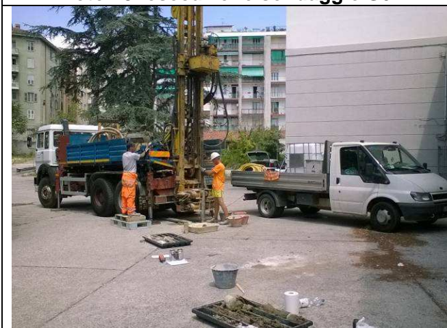
Foto 15: esecuzione sondaggio S7
