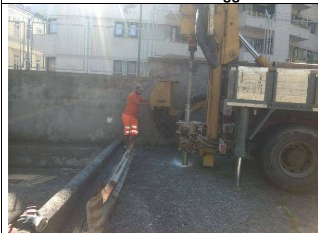
Foto 9: esecuzione sondaggio S4
