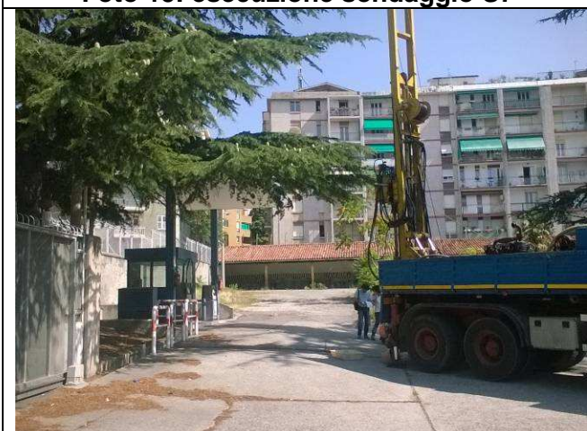
Foto 17: esecuzione sondaggio S8
